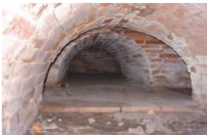
【図5】 アーチ型のトンネル
